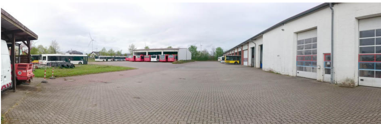
Blickrichtung Nord in den westlichen Betriebshof Dahmetal
