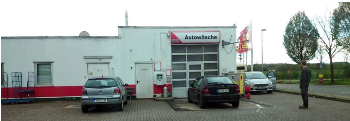
Rückseite Tankstelle mit Einfahrt Waschhalle und Hochdruckreiniger rechts vom Tor
